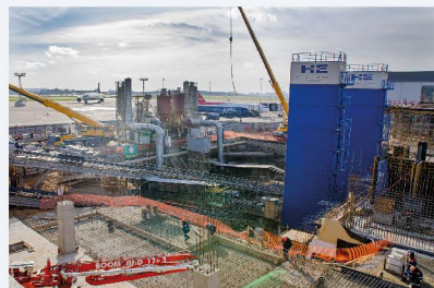
Строительные работы в аэропорту Шереметьево
