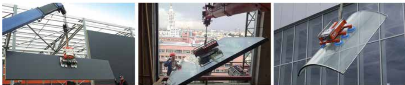
Вакуумные захваты. Монтаж сэндвич-панелей и стеклопакетов, в том числе радиальных.
