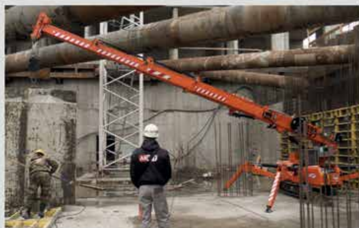
Монтаж опалубки с помощью мини-крана
