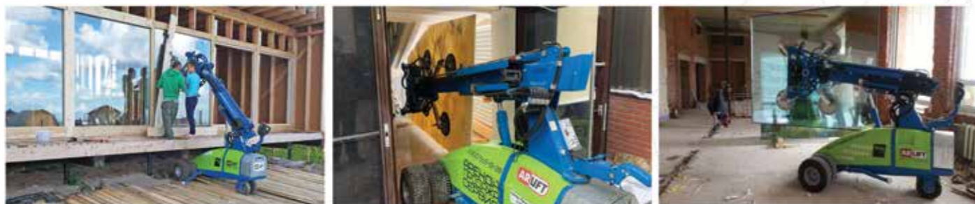
Стеклороботы. Остекление, монтаж камня, перевозка грузов.
