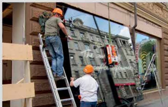
Замена стеклопакета вакуумным захватом
