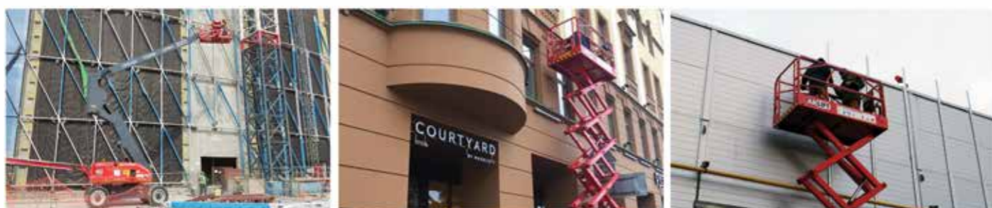
Подъемники. Внешние и внутренние работы.
