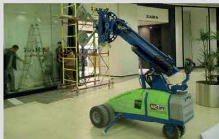
Остекление с помощью стеклоробота
