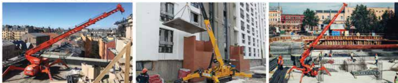
Мини-краны: монтаж опалубки, металлоконструкций, работа на перекрытиях, подъем и перевозка грузов.
