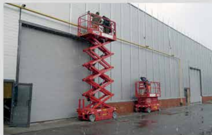
Монтажные работы с помощью ножничных подъемников
